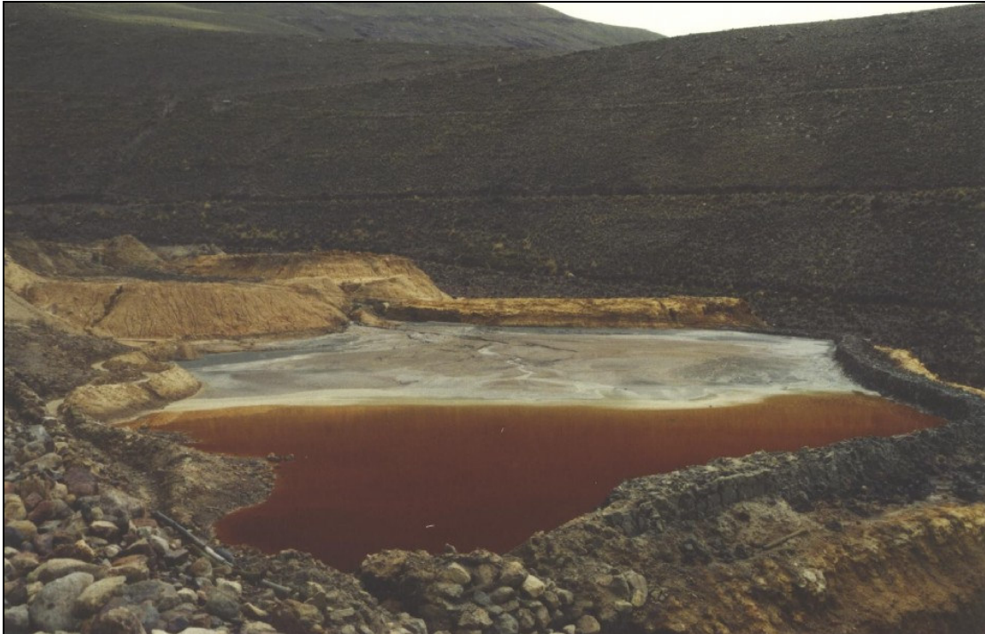
Figura 27: Los diques de cola en frente del ingenio y la casa de administración de la Empresa Minera Agrícola “Kumurana” que imponen el segundo grave problema pendiente, pues en poco tiempo es previsible que estos diques embalsarán el agua ácida del Río Kumurana, provocando una exfiltración de los diferentes minerales tóxicos contenidos en estas colas.
