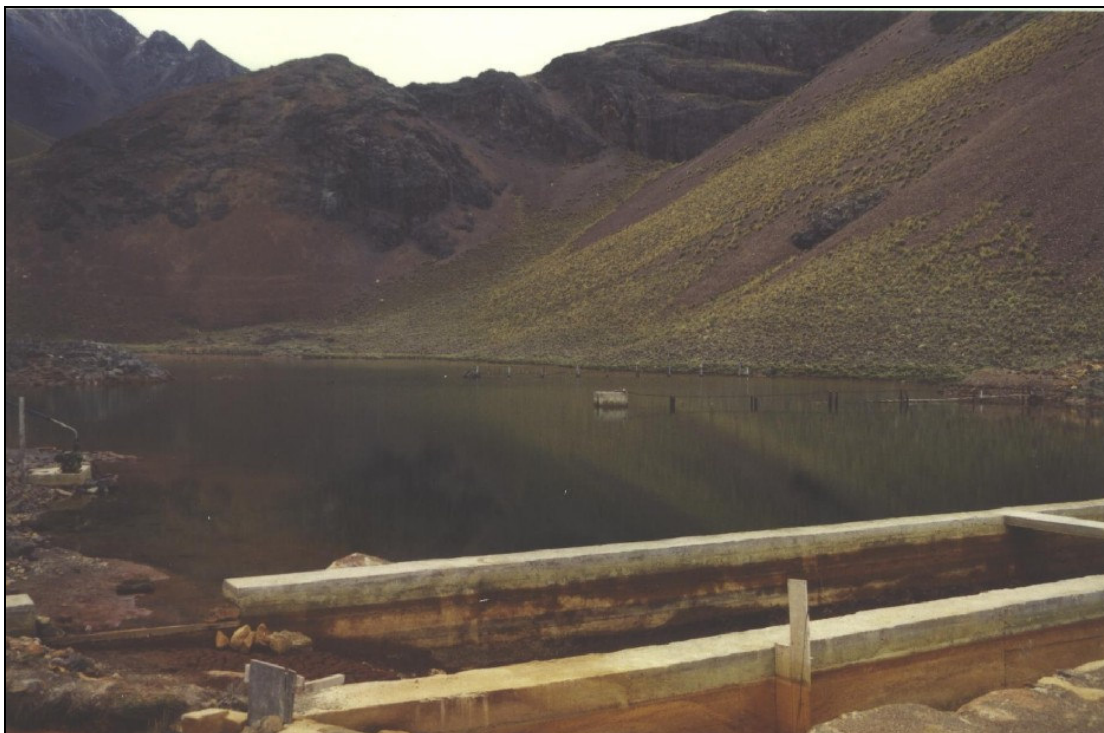
Figura 25: La laguna de clarificación con las tres cachimbas al fondo (la tercera no se percibe en esta imagen) para asegurar el segundo tratamiento físico y los tanques de sedimentación en el primer plano.
