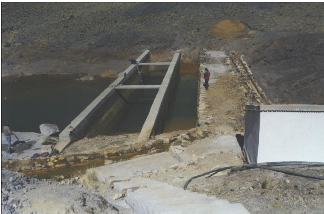
Figura 18: Terminación de las obras de construcción en la parte del tratamiento físico de la futura planta de tratamiento.
