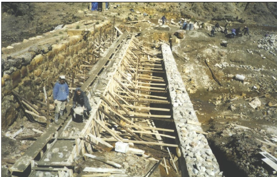
Figura 17: Construcción de los tanques de sedimentación de la planta de tratamiento Kumurana – La Lava sector Chapampa en agosto de 2002.
