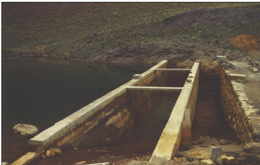
Figura 24: Los tanques de sedimentación durante su limpieza de los lodos restantes que sirven para el primer tratamiento físico.
